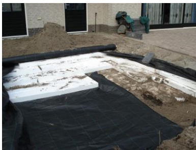
ophogen met tempex-platen
