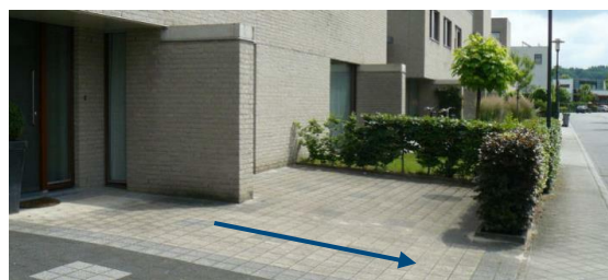
afstromingsrichting bestrating van woning af
