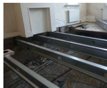
vervangen vloer door dampdichte vloerconstructie
