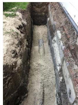
aanleg drainage langs gevel
