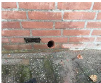
nieuwe ventilatieopening naast een bestaande
