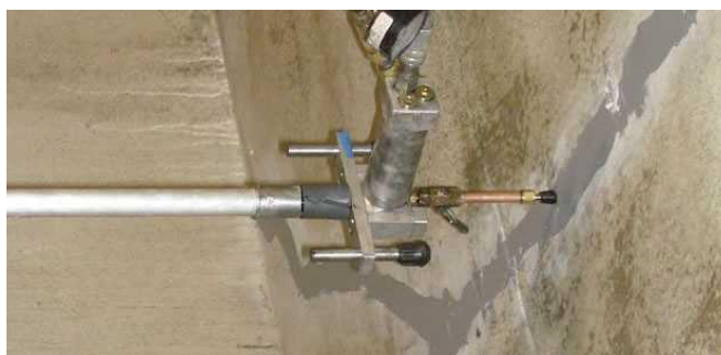
injecteren bij scheur
