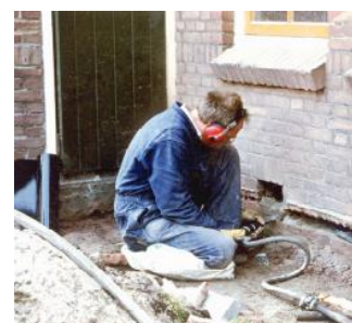
aanbrengen loodslab
